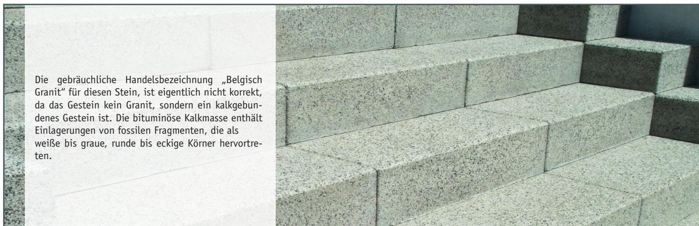
Die gebräuchliche Handelsbezeichnung „Belgisch Granit“ für diesen Stein, ist eigentlich nicht korrekt, da das Gestein kein Granit, sondern ein kalkgebundenes Gestein ist. Die bituminöse Kalkmasse enthält Einlagerungen von fossilen Fragmenten, die als weiße bis graue, runde bis eckige Körner hervortreten.
